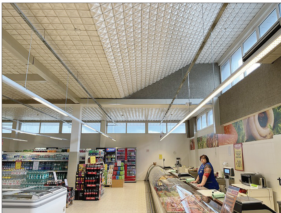
Atliekant prekybos centro „Aukštakalnis“ renovaciją paliktos autentiškos lubos iš glazūruotos keramikos
